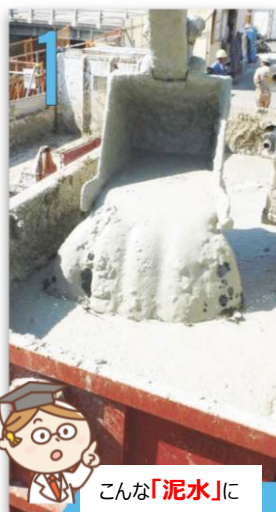
改良剤MTシリーズを投入してバックホウでかき混ぜると…
