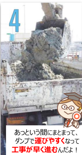
改良剤MTシリーズを投入してバックホウでかき混ぜると…
